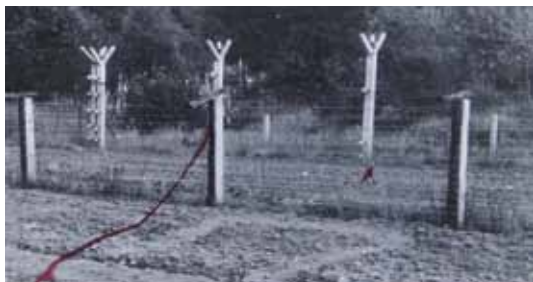
Místo v úseku poslední roty chebské brigády, kde „narušitel“ ve 22 hodin způsobil signál a stáhl se. První stěna je signální. Na druhé stěně jsou ještě vidět izolátory po osnově vodičů vysokého napětí. Orný pás před signální stěnou i mezi oběma stěnami. Tento drátěný zátaras je ve velmi dobrém stavu.
