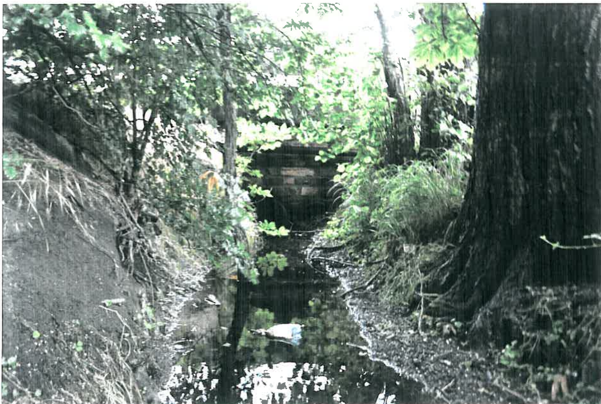
Obr. č. 6: Funkční propust za hranicí tahu obojživelníků
