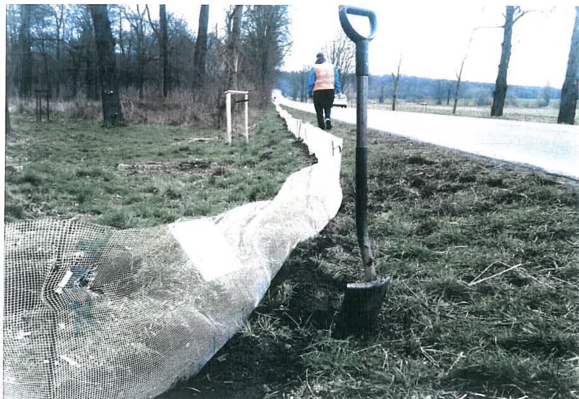
Obr. č. 8: Stavba mobilních zábran
