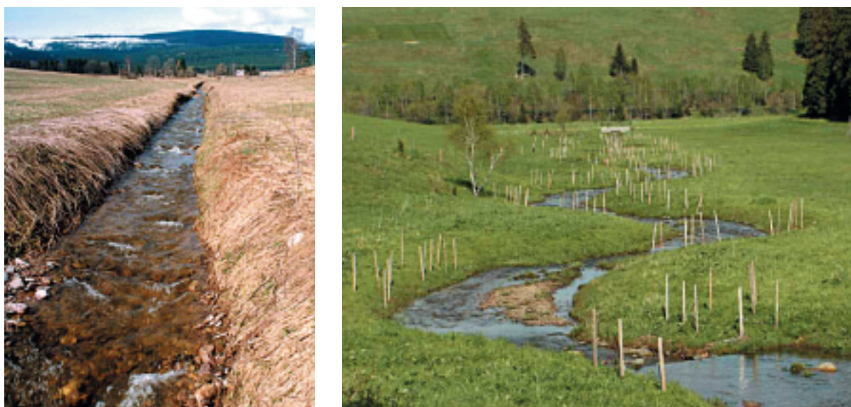
Obr. 7: Revitalizace potoka v CHKO Orlické hory, obrázek vlevo je před a obrázek vpravo po provedené revitalizaci
